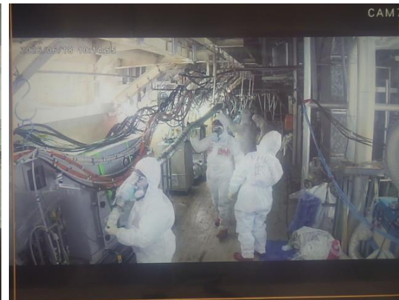
2号機内敷設状況
