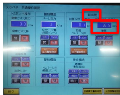
エンクロージャ気密確認状況
