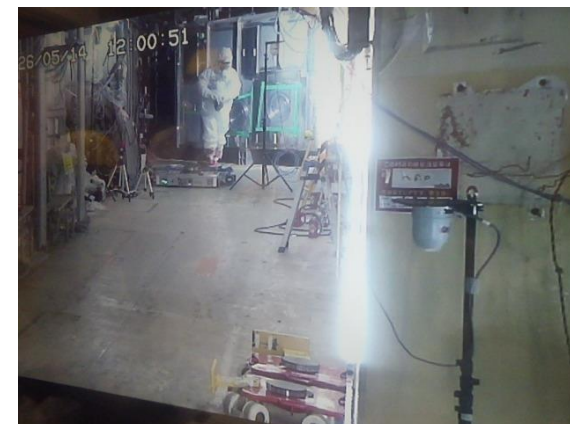
搬送台車・補助輪撤去状況
