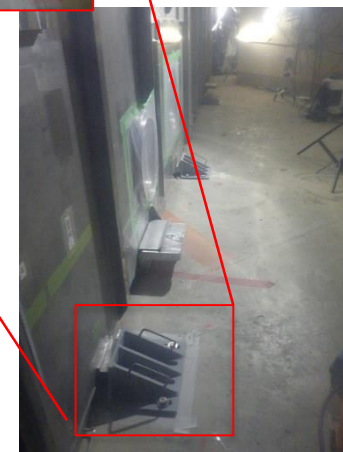
振れ止め金具設置状況
