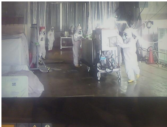
2号機内運搬状況
