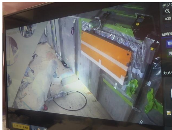
アルミ盤木へ仮置き状況
