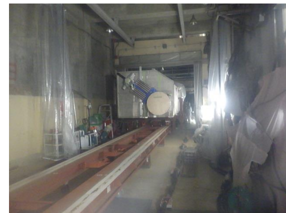
建屋内搬入状況
