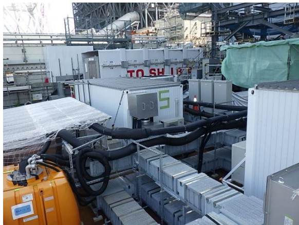
西側ヤード設備据付後
