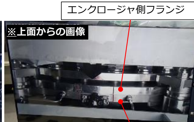
5/18 X-6ペネ接続構造・接続管に接続
