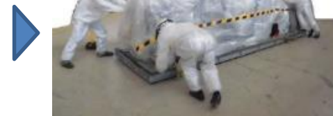
堆積物除去装置 (高圧水、AWJ) 撤去
