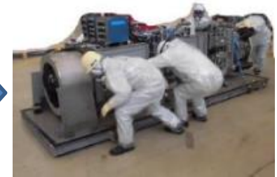
堆積物除去装置 (低圧水) 撤去
