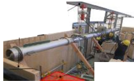
スプレー治具設置 ※X-53ペネに接続
