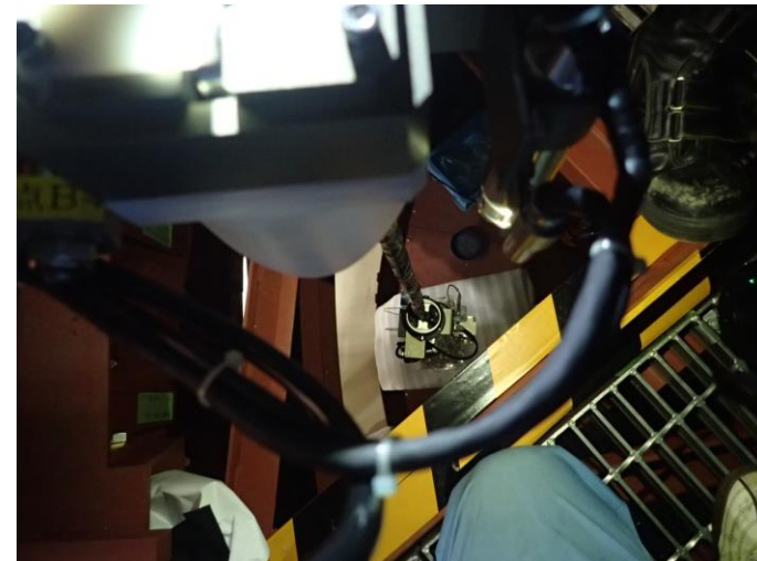
グレーチング開口部からの先端治具吊り下ろし
