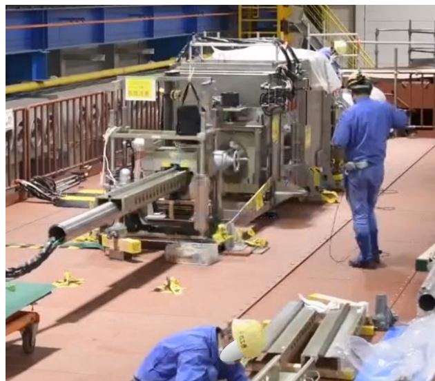
ガイドパイプの挿入
