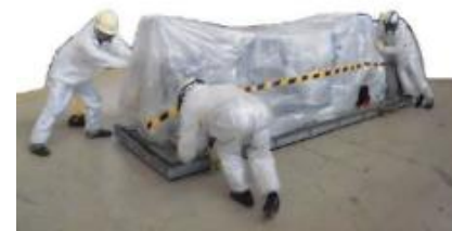
堆積物除去装置 (高圧水、AWJ) 撤去
