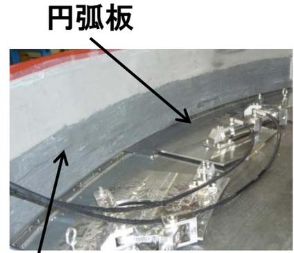
円弧板によるシール (Seal by circular arc plate)
