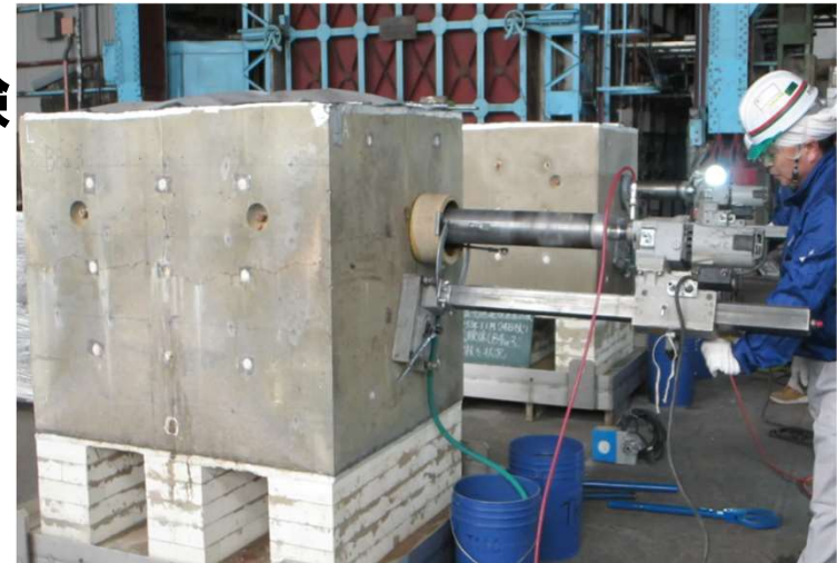
コア抜き状況 (手前:800°C試験体、奥:400°C試験体)
