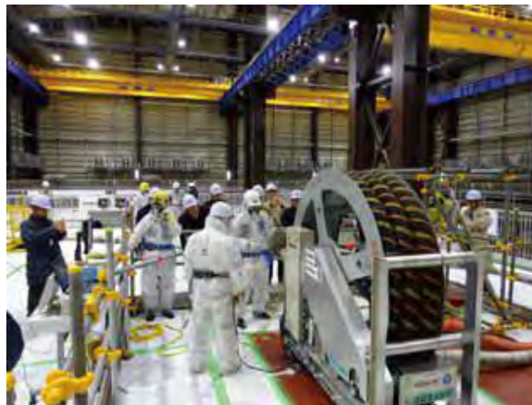
S/C脚部補強施工性確認試験
