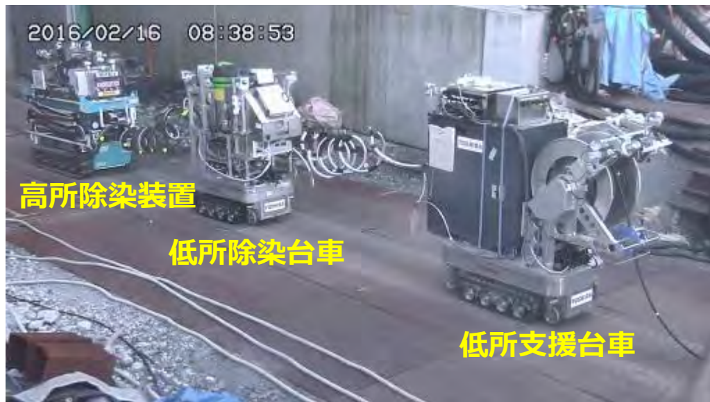
3号機R/B内への進入風景
