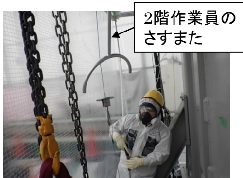
収納容器を輸送容器に格納後、 吊具を切離し
