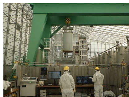
図3 クレーン設備との干渉確認
