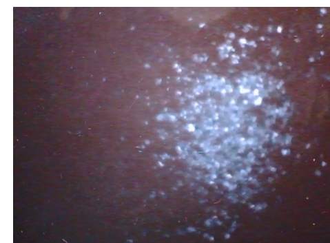
φ40 穿孔貫通後 貫通前に吸引回収を停止しているため切削片が落下 刃先が空間的に開けてることから溶接底板上に切削片が残留
