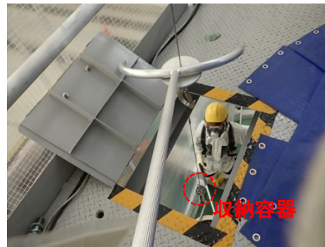
仮設ハウス1階へ下降中の 収納容器を2階から撮影
