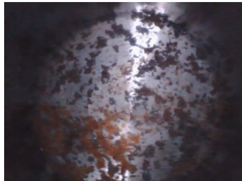
穿孔前フランジ表面状態
