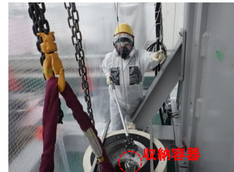
収納容器を輸送容器内容器の所定位置 に格納するためマジックハンドで微調整
