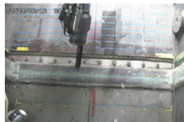
スロープ設置面の清掃
