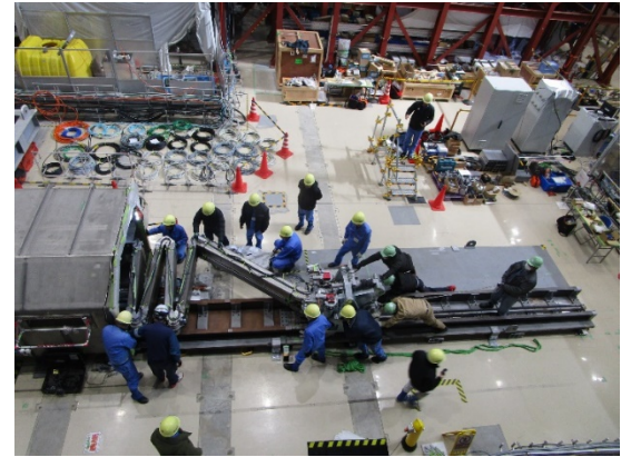
アームの組込み作業状況
