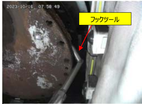
フックツールのハッチへの引っ掛け
