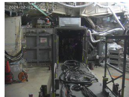
ロボット搬入部屋内へ の移送状況
