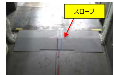
スロープ設置状態
