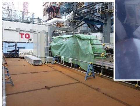
A視 作業前状況
