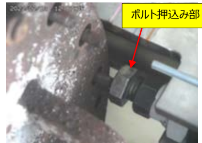
エアシリンダ押し込み治具による押し込み
