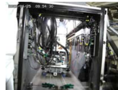
ロボット搬入部屋内への設置
