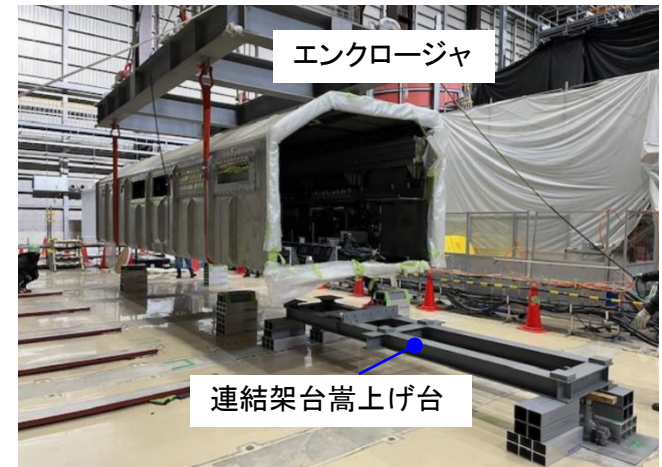
エンクロージャの準備作業状況
