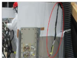
外側敷設ケーブル（黒色テープ）
