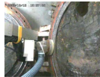
レーザ清掃装置 照射前
