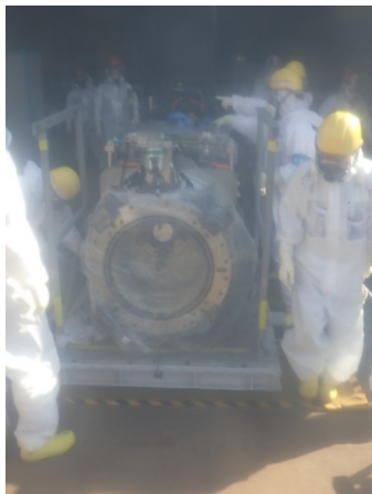
大物搬入口からの搬入作業
