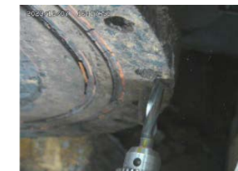
フラットドリル 付着物除去中
