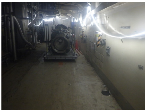
2号機内運搬状況
