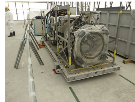
2号機内搬入のためのスキッドへの設置状態
