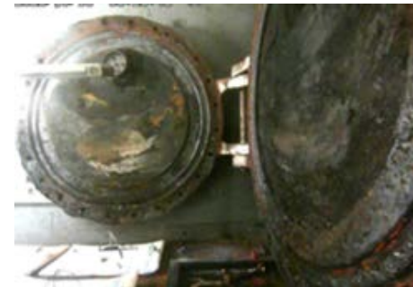
ハッチ開放後の状態
