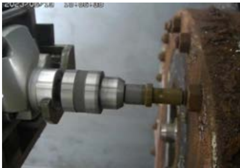
ホールソーによるナット除去加工
