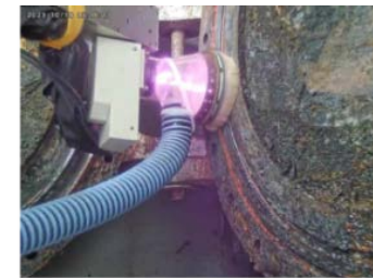
レーザ清掃装置 照射中
