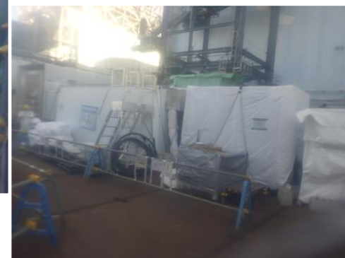
A視 作業後状況
