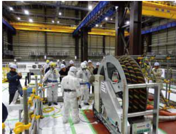
S/C脚部補強施工性確認試験
