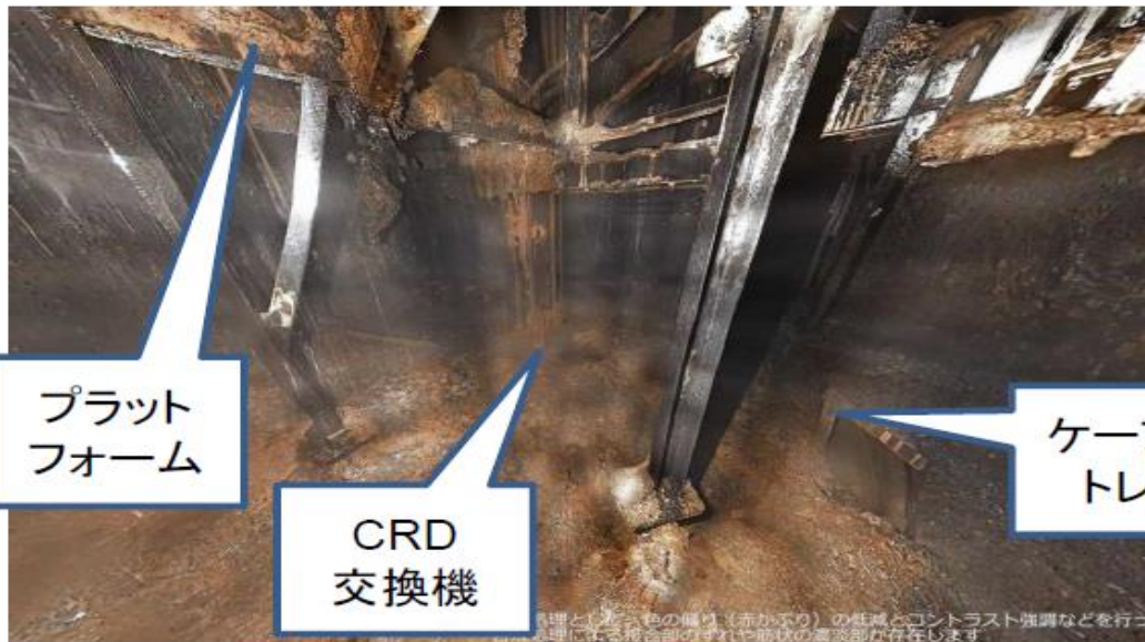
2号機 ペDESTAL床エリアの広角写真(東電HPより)
