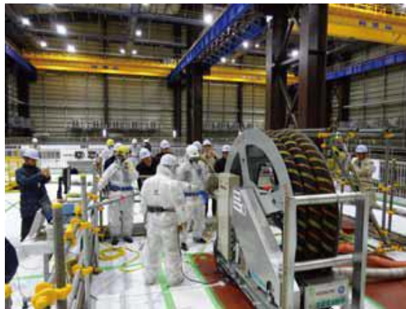
S/C脚部補強施工性確認試験
