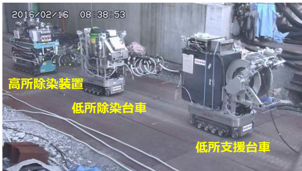
3号機R/B内への進入風景
