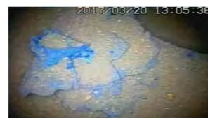
⑤ピーモルフ2で撮影した1号機ペDESTアル外地下1階
