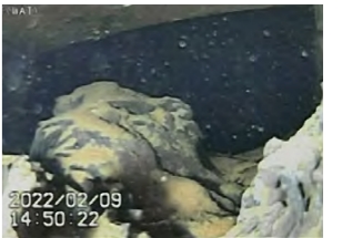
⑨ IRIDOLPHIN-A で撮影した1号機ペDESTアル開口部内部
