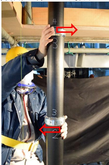
3段目が傾斜するようにパイプに曲げ方向の力をかけている様子
