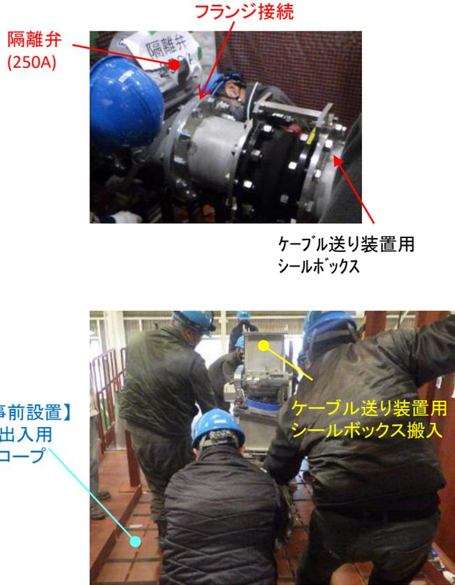
図64 ケーブル送り装置用シールボックスの搬入・設置状況
