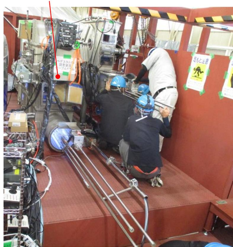
図63 調査装置用ケーブルドラム・シールボックスの設置状況
