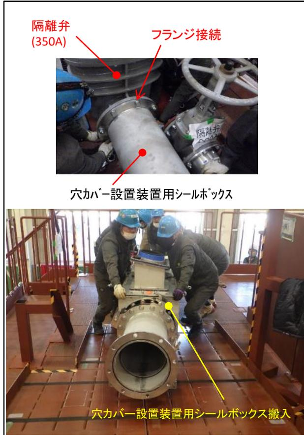
図65 穴カバー設置装置用シールボックスの搬入・設置状況
