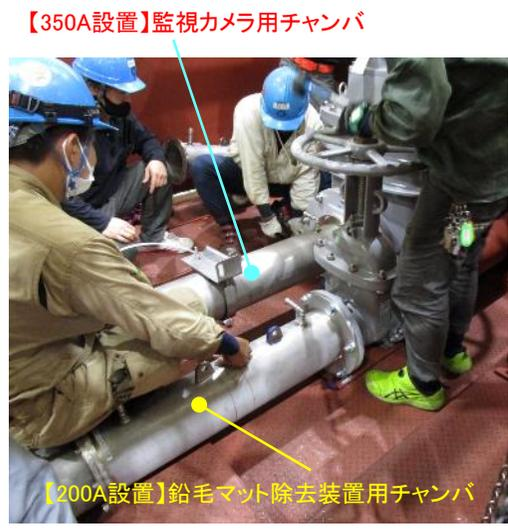
図71 監視カメラ用チャンバの設置状況(350A)
