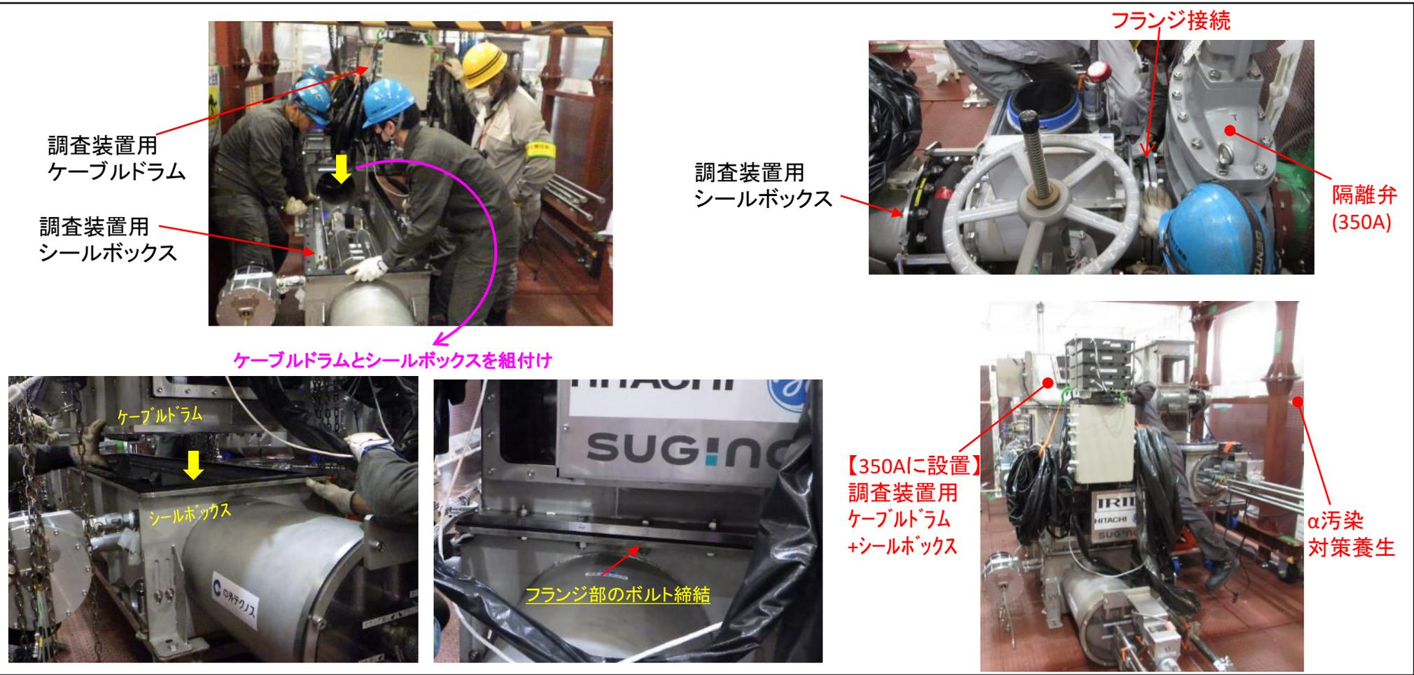
図68 調査装置用ケーブルドラム・シールボックスの設置状況
