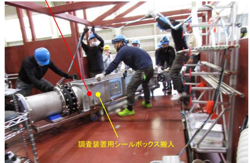
図62 調査装置用シールボックスの搬入状況
