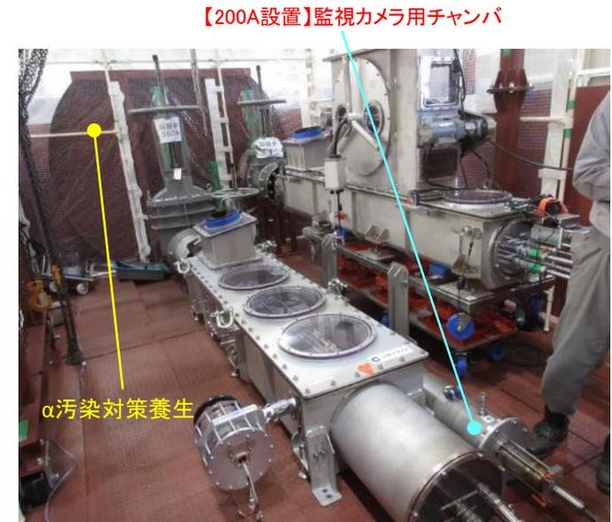
図77 監視カメラ用チャンバの設置状況(200A)
