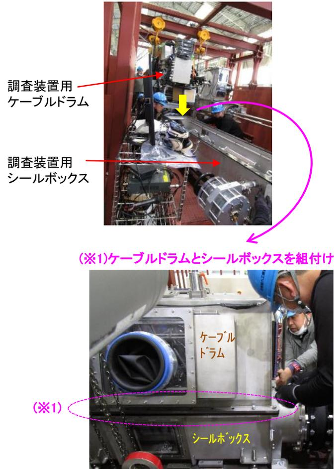
【350AIに設置】調査装置用ケーブルドラム+シールボックス
