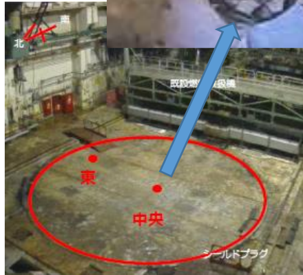
シールドプラグの穿孔箇所
