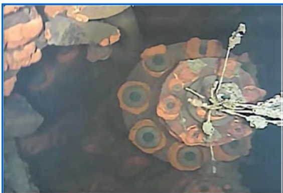
CRDフランジ状況
