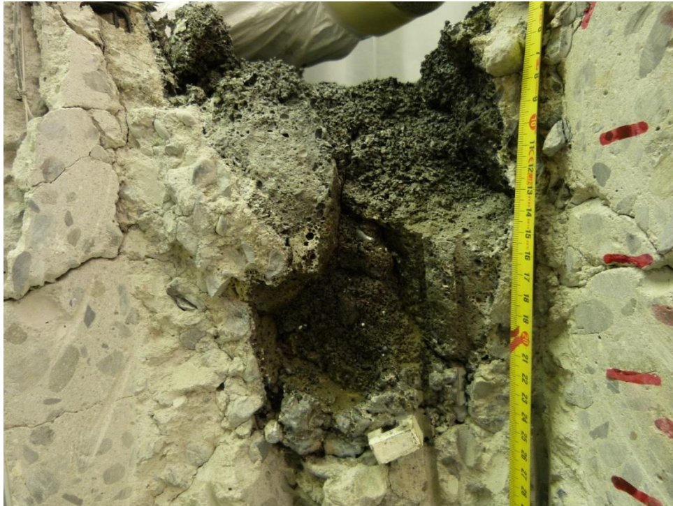
VF-U1 試験部の断面写真*
