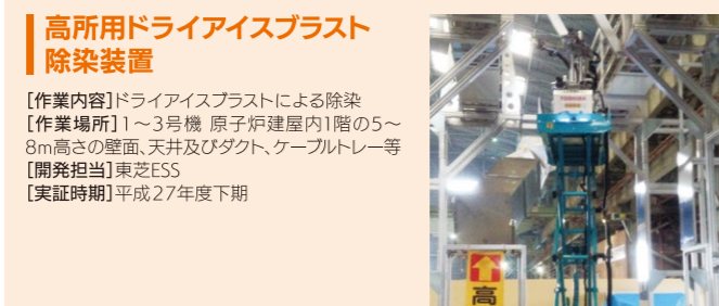
写真は吸引・プラスト作業タイプ
