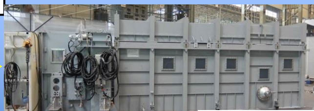
隔離部屋組立状態
