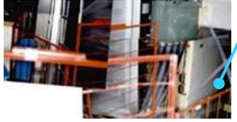
CRD開口                                        | 構造物等により調査装置がCRD開口からペDESTAL内に進入できない。                         | 調査装置本体はCRD開口からペDESTAL内に進入せずに、調査計器付き伸長ロッドをペDESTAL内に伸長させる。    |
