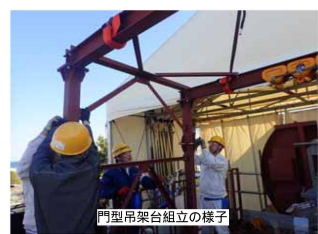
搬入用スロープ・門型吊架台搬入/据付のトレーニング状況
