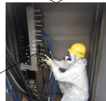
ケーブルラックのパネル化
