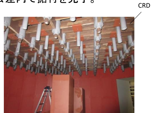
ペDESTAL内部の様子
