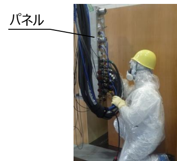
ケーブル解線の作業性向上 (パネル化)
