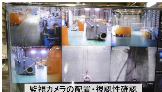
監視カメラの配置・視認性確認
