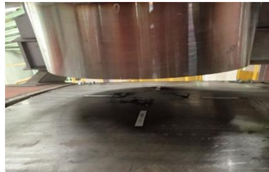
延長配管とS/C表面のずれ状況
