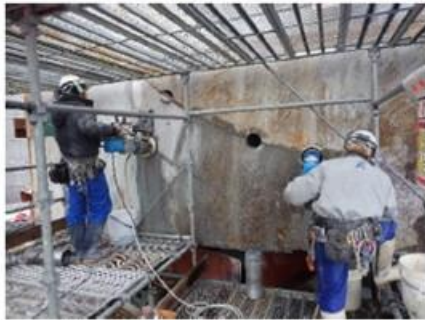
水平コア削孔状況
