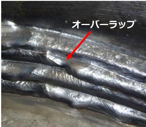
VT状況【356°付近】
