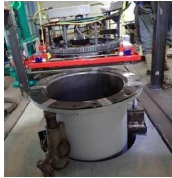
位置合せ装置撤去状況
