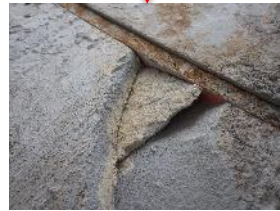
ひび割れ露出部に補修材と同系色の成分を確認した。 (試料採取，分析を実施⇒次次葉、4)項)
