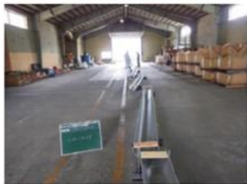
水路設置状況
