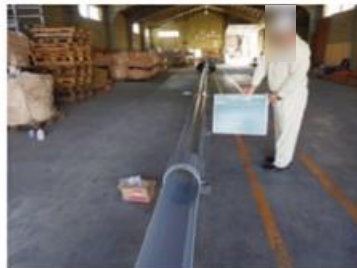
水路設置完了
