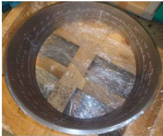
延長配管下端部
