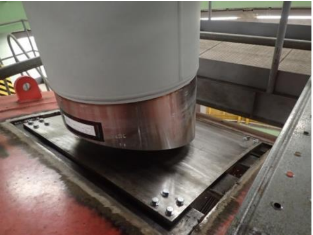
延長配管(下端部), S/Cシェル
