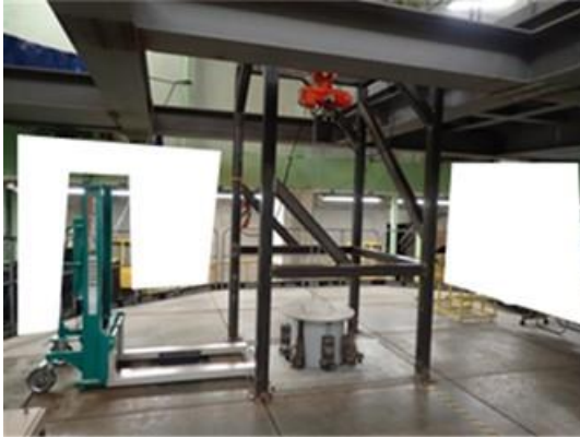
延長配管仮固定状況
