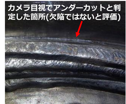
VT状況【18°付近】
