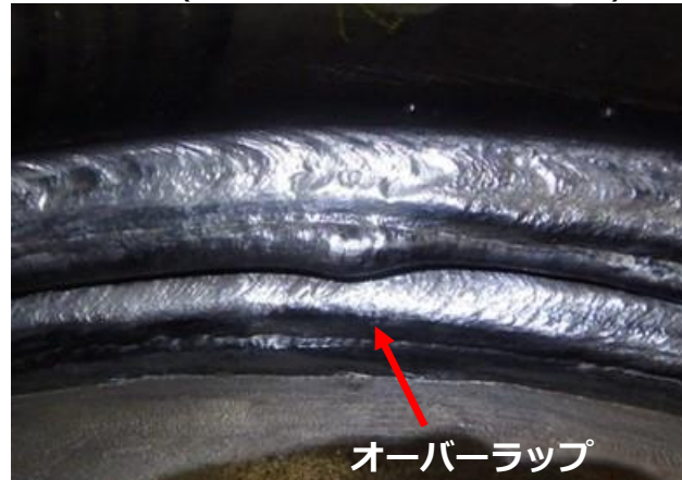
VT状況【288°,294°付近】
