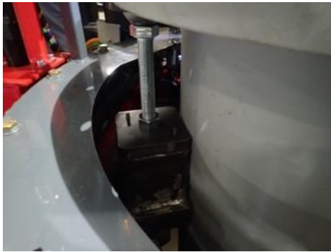
仮設支持材による固定
