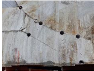
水平コア削孔位置 (写真)
