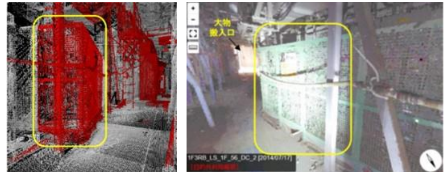
③-1 盤の保護柵：セルと干渉する
