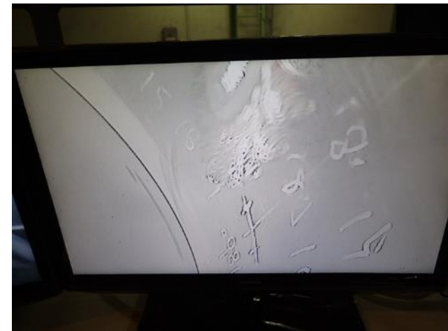
磨きによる浮き錆除去後の溶接施工部 (カメラ映像)
