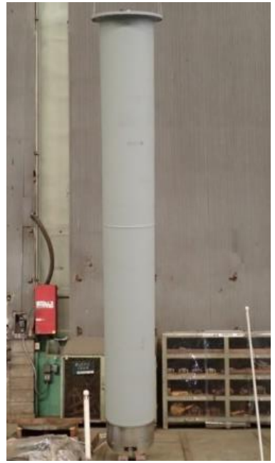
延長配管(全体)
