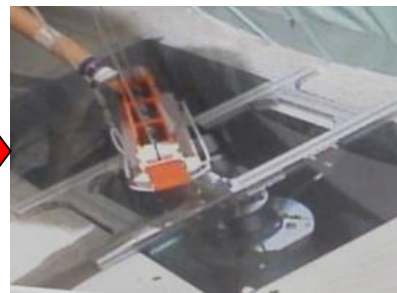
ポンプ吊り降ろし・設置
