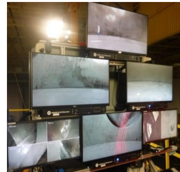
モニタリングツールでの 延長配管-S/C表面の監視(No.7)
