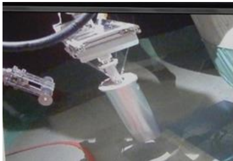
ポンプ吊り降ろし・設置
