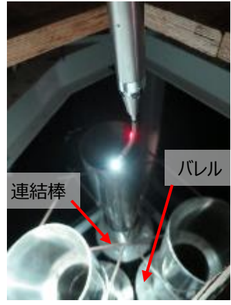
蒸気乾燥器底板下 (気水分離器上部) 調査の様子
