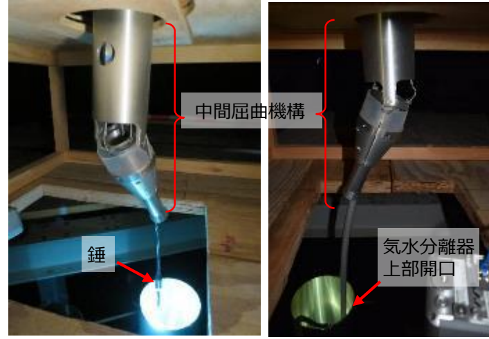
調査装置ALB 調査装置AHB 気水分離器上部開口へのアクセスの様子
