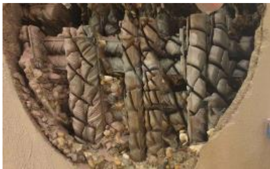
要素試験における生体遮蔽壁内の主鉄筋切断状況
