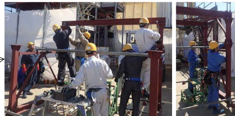
門型クレーン組立トレーニングの様子
