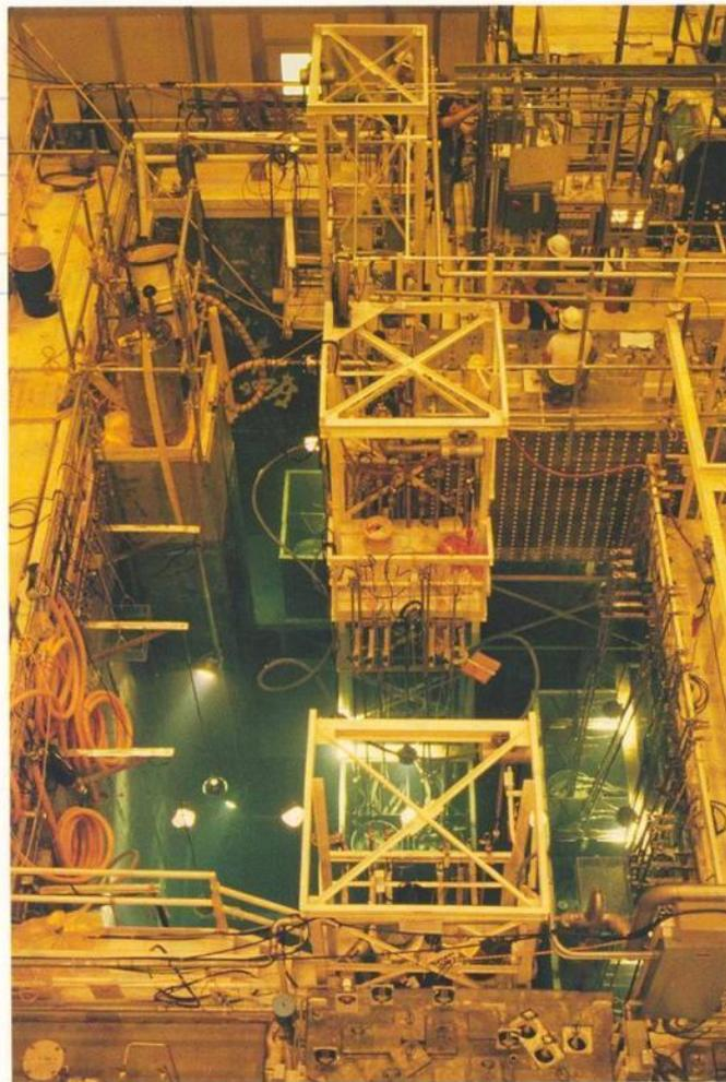
利用可能な最高の技術であるSDS (Submerged Demineralizer System : 浸漬脱塩システム) をベースとし、段階的な水浄化システムを開発
