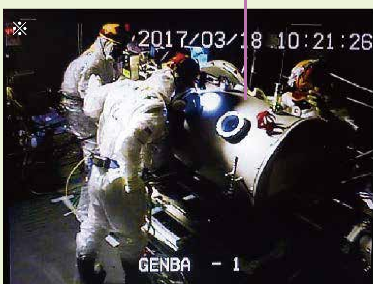
PCV内投入時 (現地状況)
