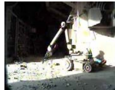
3号機大物搬入口のガレキ撤去 (2011.11.3)
