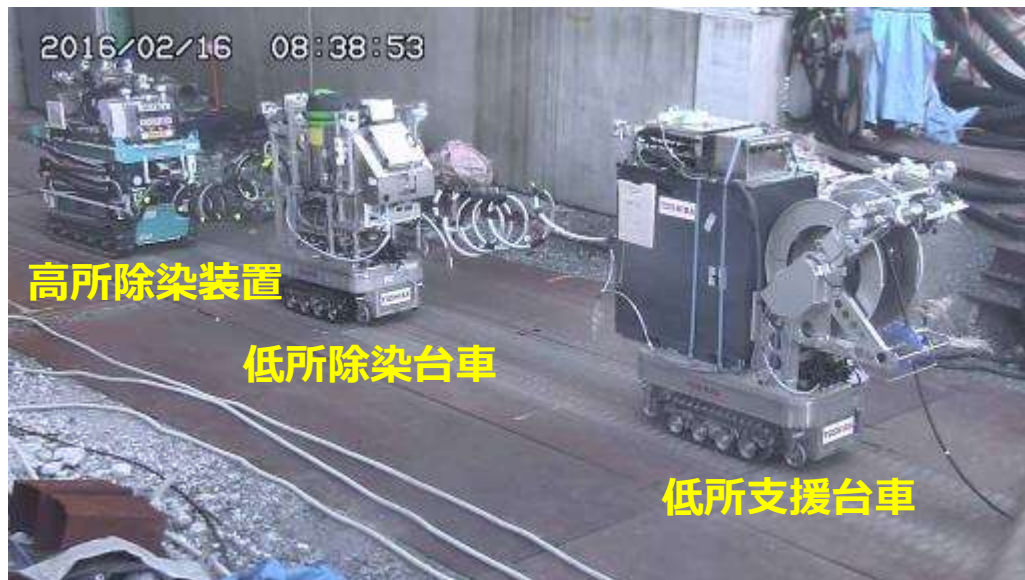
3号機R/B内への進入風景
