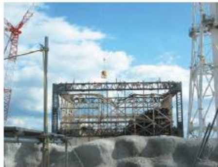
1号機原子炉建屋西側 (35m 盤より) (ちょうどカバーが外されていた)
