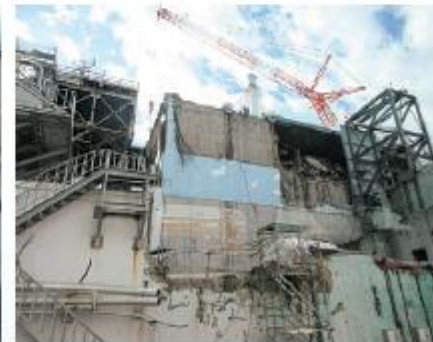
3号機原子炉建屋北側
