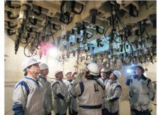
格納容器ペDESTAL内で説明を 受けている様子 (第2班)
