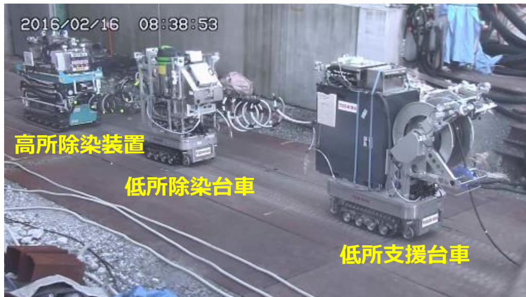
3号機R/B内への進入風景
