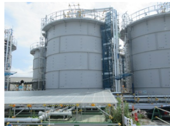
汚染水タンク
