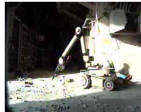
3号機大物搬入口のガレキ撤去 (2011.11.3)
