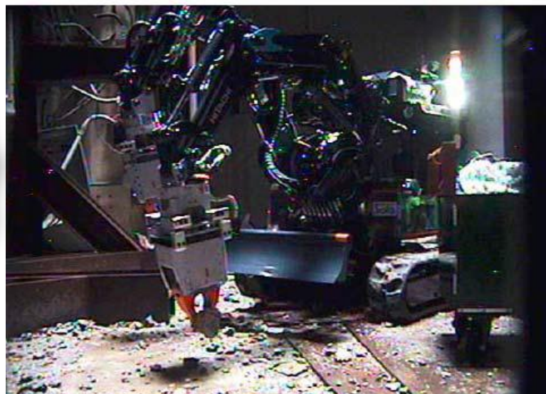
3号機大物搬入口周辺の障害物除去 (2013.7.25-8.23)
